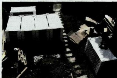
Kollektoren warten auf die Montage auf dem Dach.
